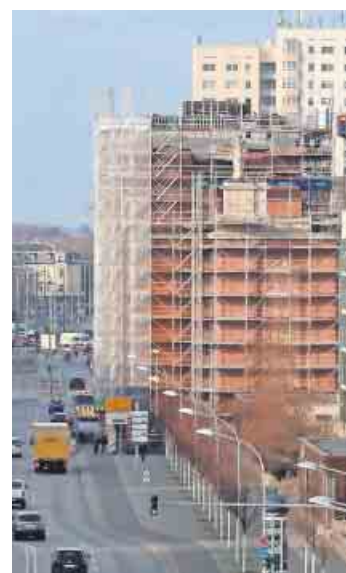
Seit 2017 im Bau. Der Turm der Potsdamer Garnisonkirche.
