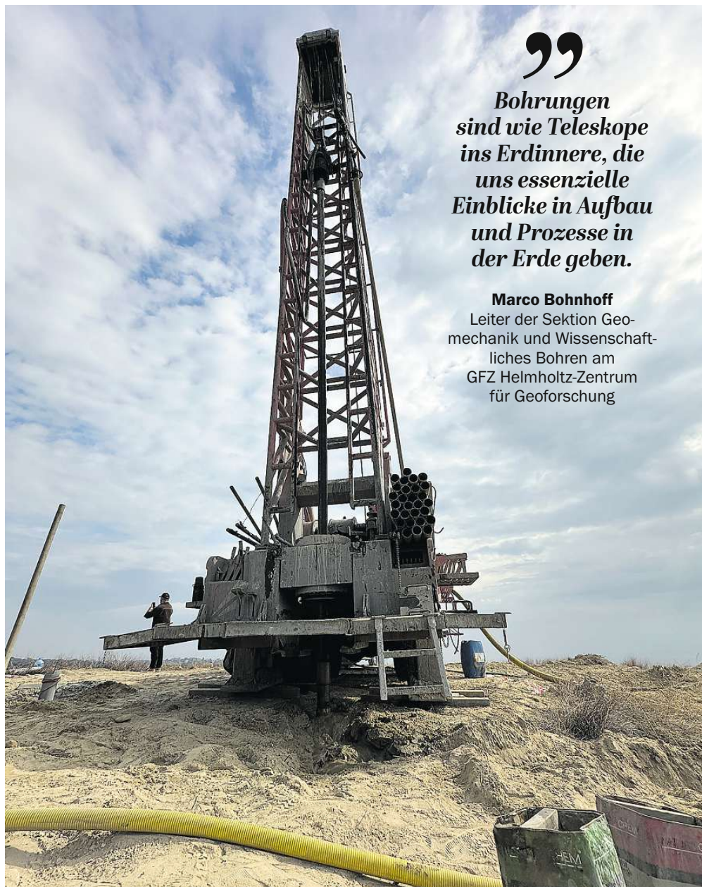
Erdbeben im Blick: Bohrung für eine von zehn Messstationen am Marmarameer nahe Istanbul
